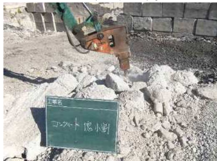
コンクリート塊小割
