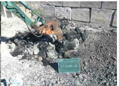
アスファルト塊小割
