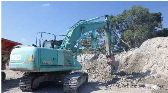
小割機にて小割 (磁選機付き) 鉄筋等の異物除去
