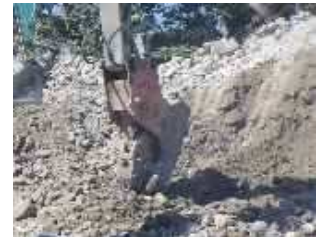
小割機にて小割 (磁選機付き) 鉄筋等の異物除去
