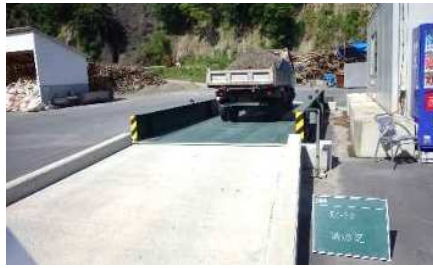
原材料（コンクリート塊）の搬入
