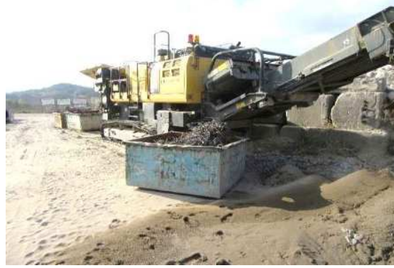
磁選機による金属類の除去状況
