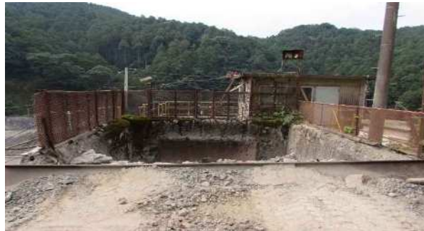
破碎プラントへの 投入口
