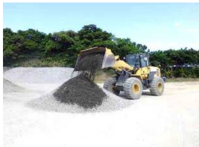
⑩再生材と新材の混合 ・RC-40(Co50%,As20%)と新材碎石を タイヤショベルで7杯、3杯の割合で 計量・混合して製品とする
