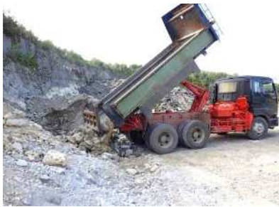
③保管場所 (荷下ろし状況) コンクリートとアスファルトは 混ざらないように保管
