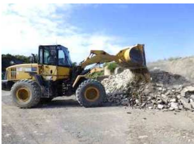
⑤コンクリートとアスファルトの混合 ・小割したコンクリート塊と アスファルト塊を、タイヤ ショベルで5杯、2杯の割合で混合
