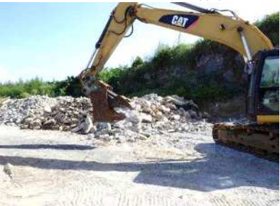
④小割・異物選別 ・大物材について小割 ・磁選機付きの重機で鉄筋等の異物除去
