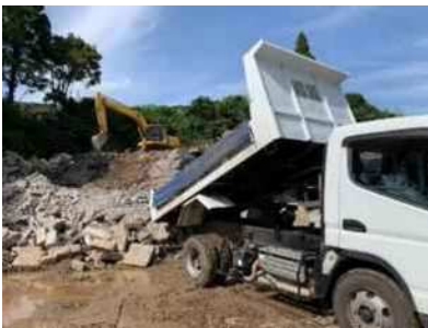
③保管場所 (荷下ろし状況) コンクリートとアスファルトは 混ざらないように保管
