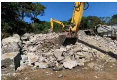
⑤コンクリートとアスファルトの混合 ・小割したコンクリート塊と アスファルト塊を、 バックホウで5杯、3杯の割合で混合
