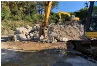
④小割・異物選別 ・大物材について小割 ・磁選機付きの重機で鉄筋等の異物除去
