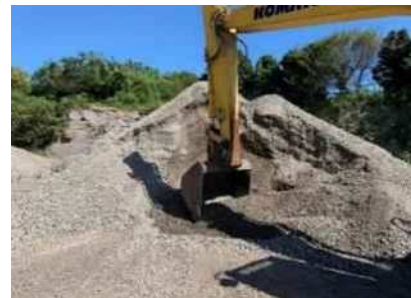
⑭ 再生材と新材の混合 ・ストックヤードにある新材RC-40とRC-40(Co50%,As30%)をバックホウで1対4の割合で計量 ・バックホウで混合して製品とする
