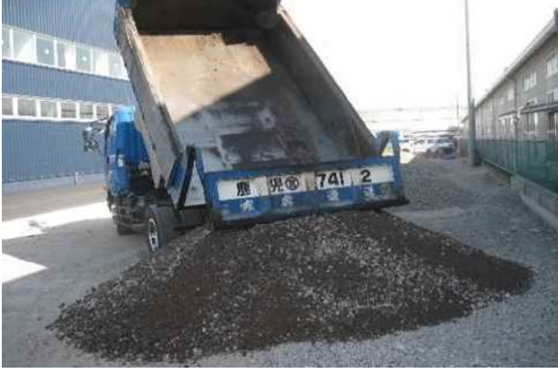
路盤材・基礎材現場搬入
