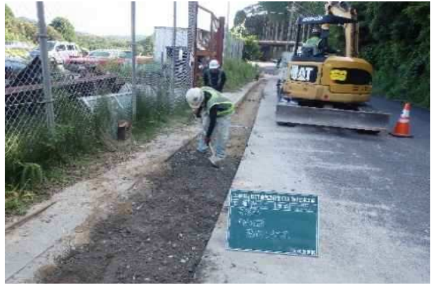
現場施工(路盤材敷均し状況)
