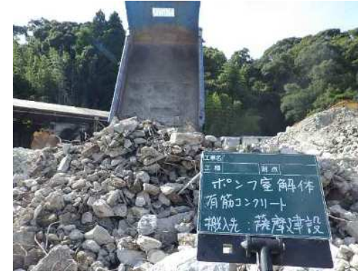
③荷降ろし状況
