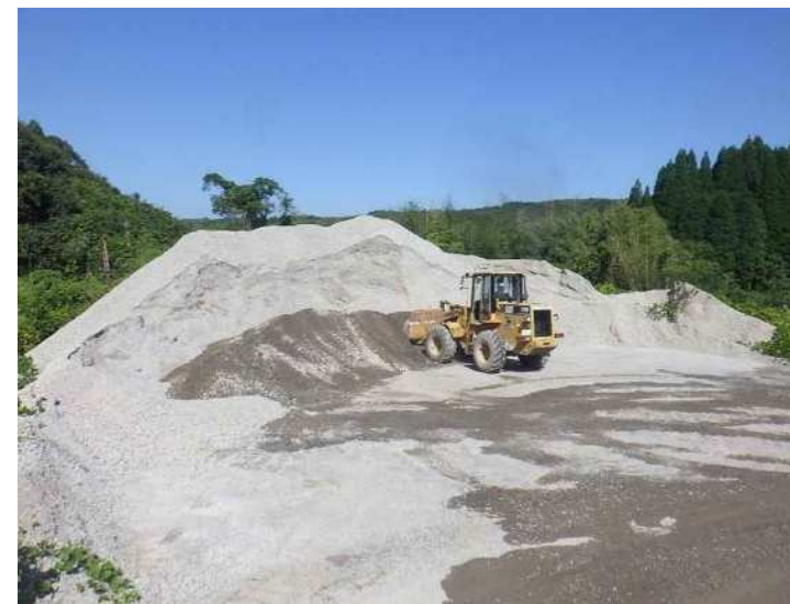
⑦ストックヤードに保管状況
