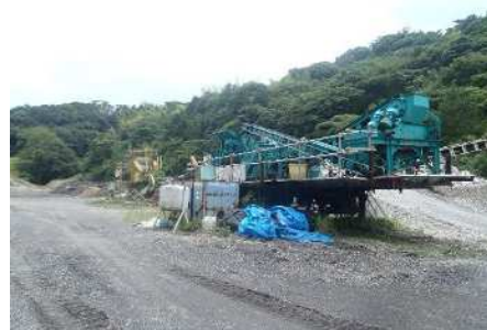
二次破碎処理施設 (株)古川金属機械(株)製 移動式古川リプランF40TR型
