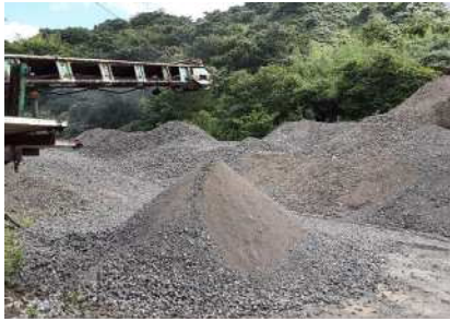
⑪二次破碎後の製品出口
