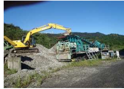
⑥二次破碎機(リプラン)に投入
