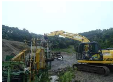
③小割して一次破碎機に投入
