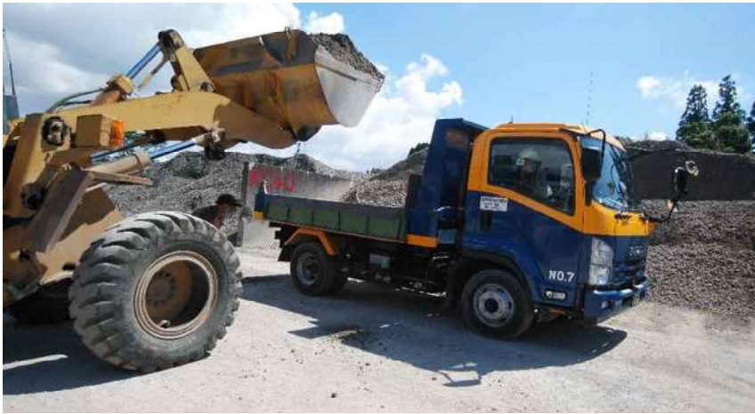
出荷のためダンプへ積み込み
