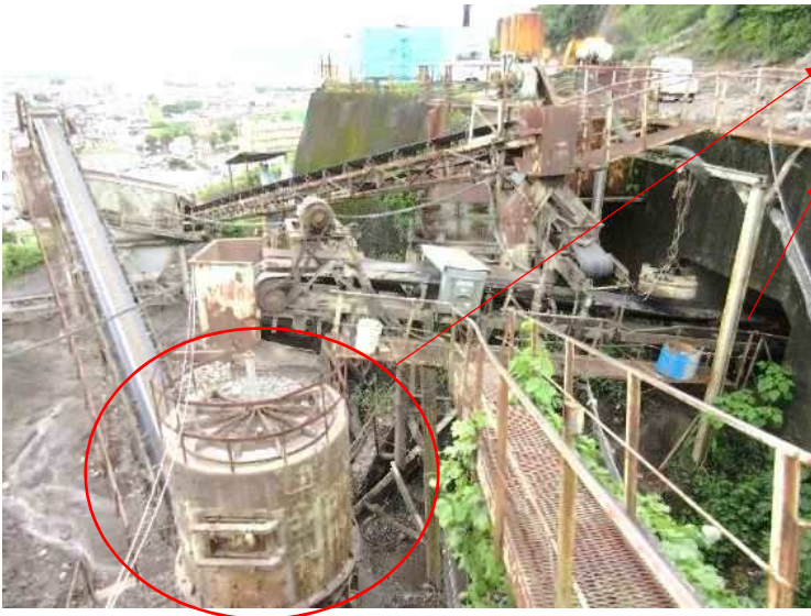
2次破碎 (シュレッダーによる破碎) 2次ストック落ち口
