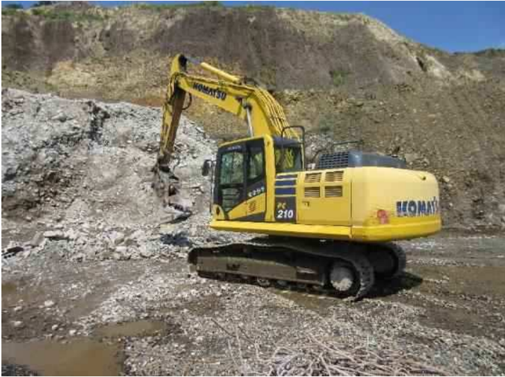
油圧ショベルによる小割作業 (磁選付き小割機) (鉄筋・異物除去)
