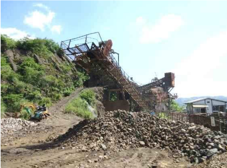
2次破碎ストック置場
