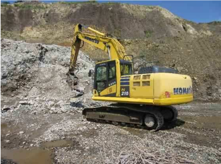
油圧ショベルによる小割作業 (磁選付き小割機) (鉄筋・異物除去)
