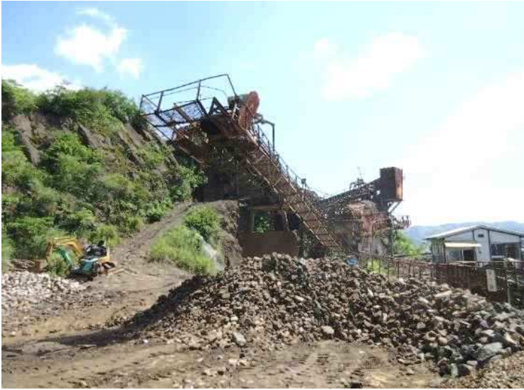
2次破碎ストック置場
