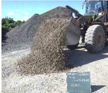
混合作業 タイヤショベル(3.8m 3 )にて計量
