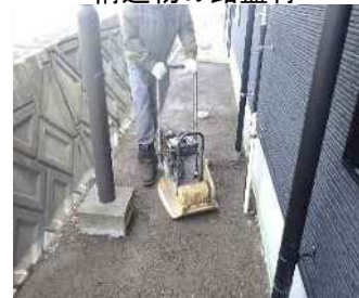
構造物の路盤材
