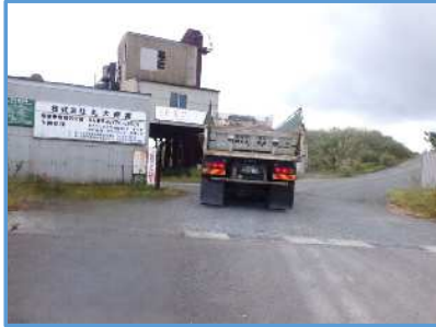
コンクリート塊の処理
