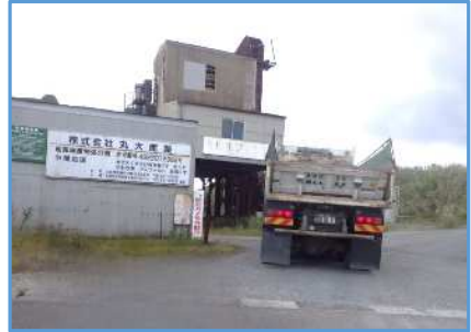
アスファルト塊の処理
