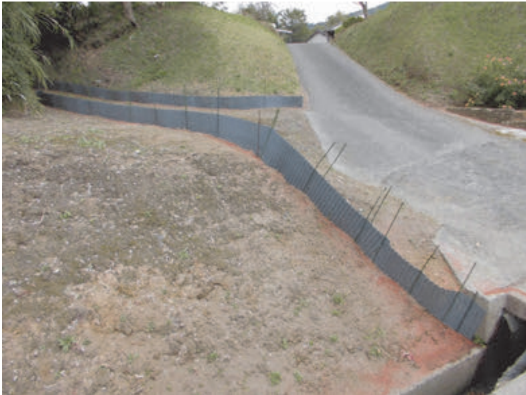
鹿屋市が設置した「侵入防止用アゼシート」
