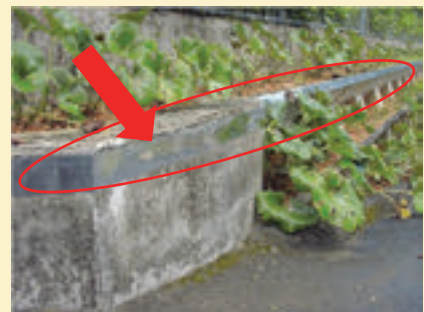
ステンレス板施工例（図中の赤矢印部分）
