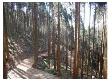
作業路網の整備
