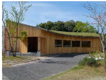
木造施設等の整備 ShopBot工房(鹿児島市)
