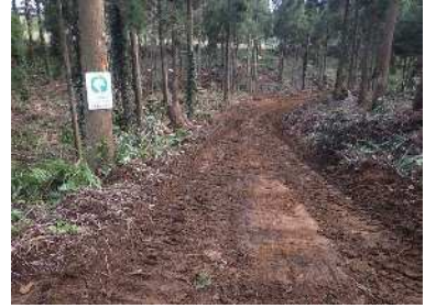
作業路網の整備
