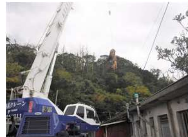
枯損木の伐倒・除去
