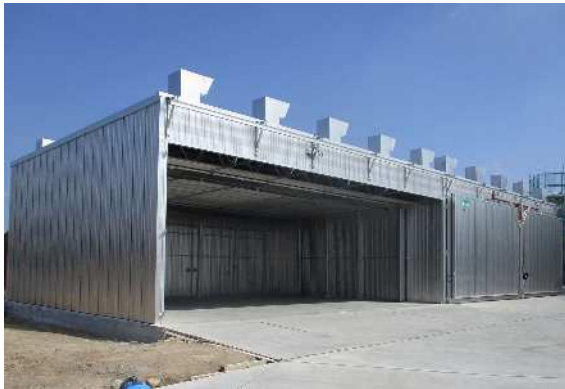
木材加工流通施設の整備 〈中温乾燥機〉 (力強い木材産業生産性強化対策事業)
