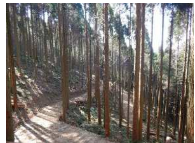
作業路網の整備
