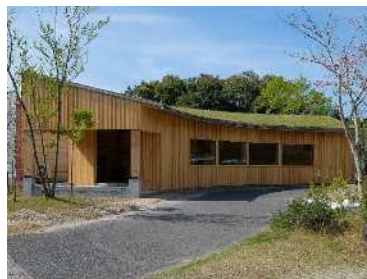
木造施設等の整備 ShopBot工房(鹿児島市)
