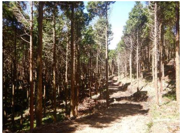
森林作業道の整備 (ふるさとの森生産性強化対策事業)
