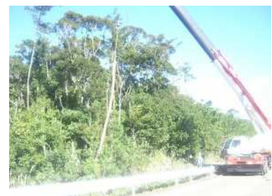
枯損木の伐倒・除去
