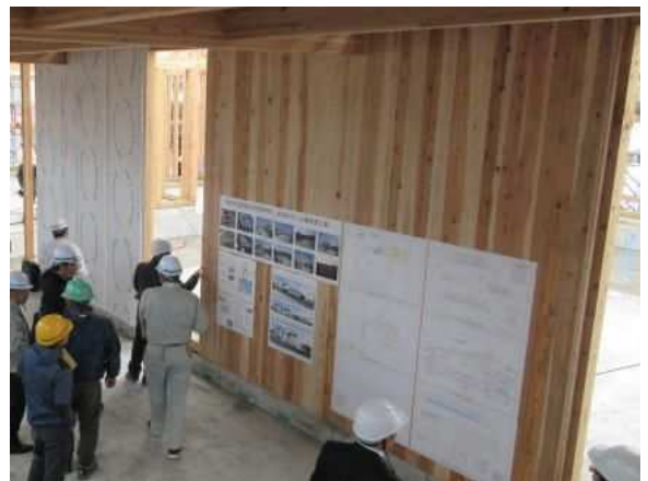
構造見学会 (CLT使用建築物) (CLT等中高層建築物利用拡大事業)
