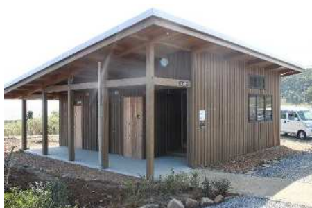
木造施設の整備 コミュニティハウス(屋久島町)
