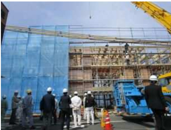
木造事務所（CLT）の構造見学会 (CLT等利活用加速化事業)
