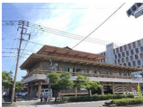
築48年(1972年7月竣工)以上の県武道館
