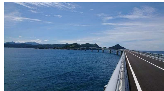
甑島縦貫道（甑大橋）開通
