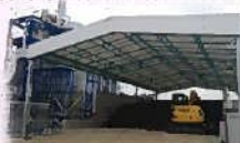
燃料投入ワーキングフロア
