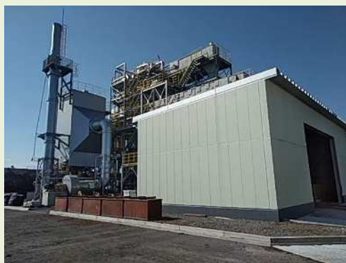
写真(左側)全体外観 写真(右側)燃料受入用 ホッパ
