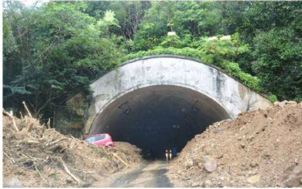
写真：土石流により不通となっていたトンネル (鹿児島県大和村 H22.10)
