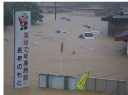
写真2：豪雨により浸水する集落（鹿児島県奄美市 H22.10）
