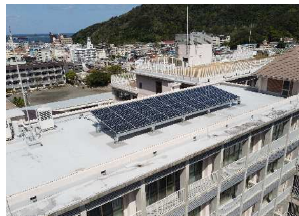
太陽光パネルを 校舎屋上に設置
