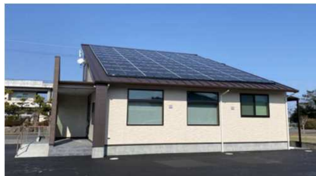
↑ 太陽光パネル（事務所屋根）
