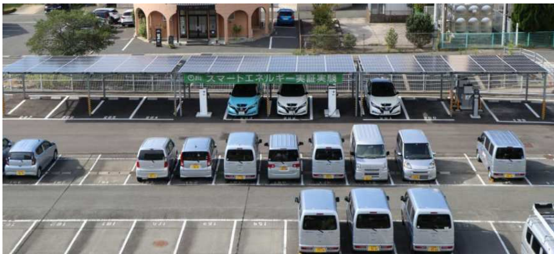
▲カーポート PV (16.5kW)
