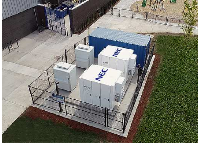
図 1-22 小学校周辺地域のエネマネ用に導入された大型蓄電池 (米国オレゴン州の事例、1,000kWh)
