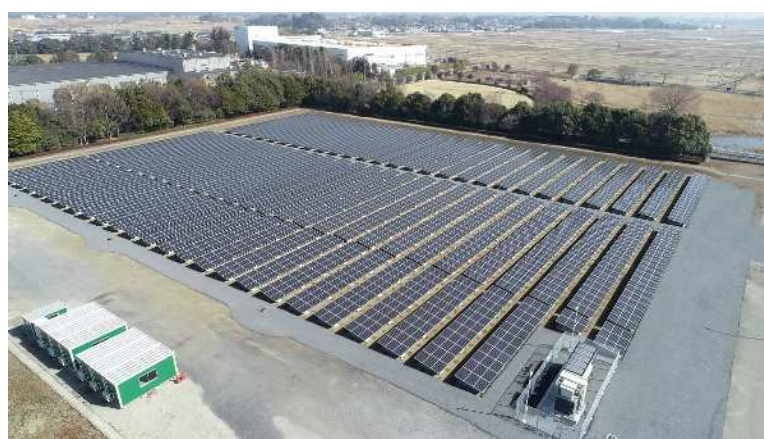
図 1-25 化学工場に導入された自家消費型の太陽光発電所の例 (約 1.3MW)
