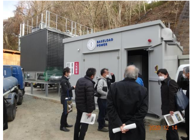
シカパワー地熱発電所
