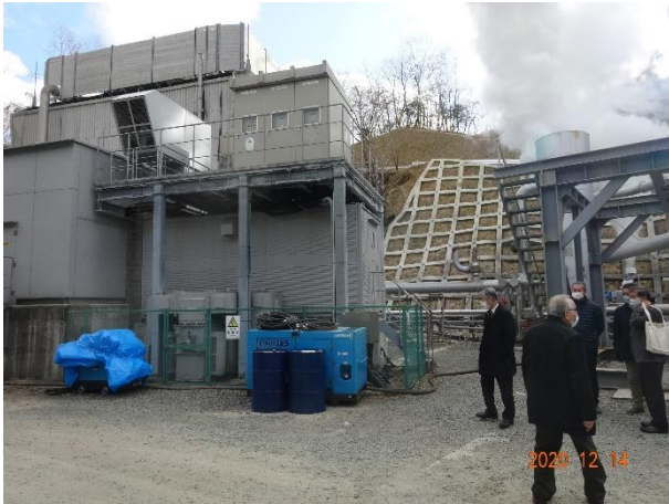
わいた地熱発電所
