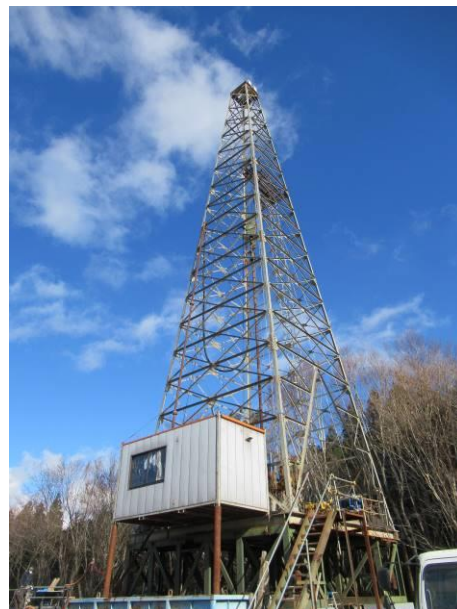
2号生産井掘削現場
