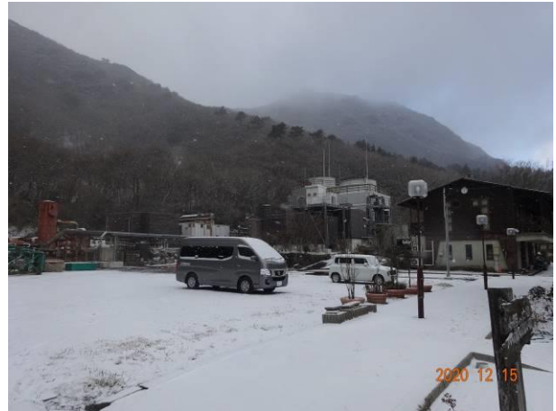
九重地熱発電所
