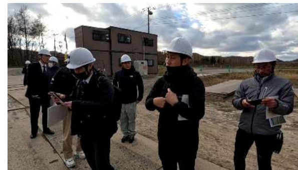
湧別町バイオガスプラント建設現場の視察状況
