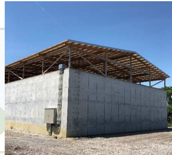
消化液貯留槽(宮崎県新富町) 最大貯留量:冬季3か月分(12~2月)
