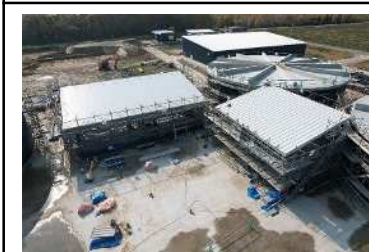
ホイラー室(左)と ガス前処理施設(右)
