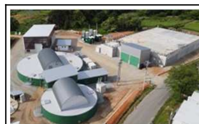
バイオガスプラント全景
