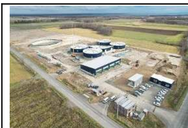
バイオガスプラント全景
