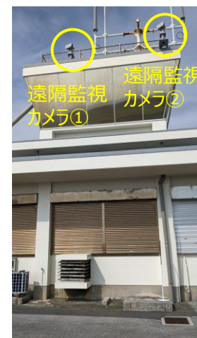
旧管制塔（エプロン側から撮影）
