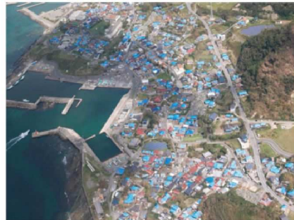
<強風により屋根瓦が飛散した千葉県館山市の状況>
