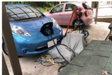
停電時に給電中の24kWh日産リーフ
