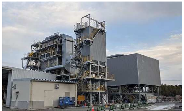
さつま町バイオマス発電所
