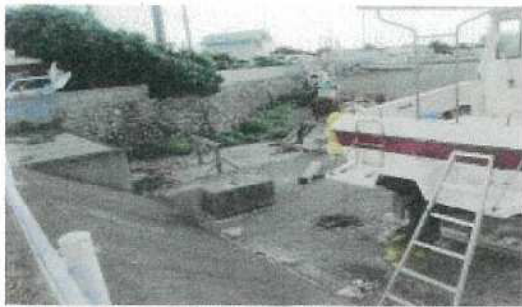
⑪石積み岸壁
