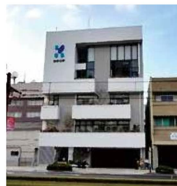
萩原技研新社屋ビル
