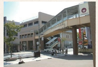
霧島中央歩道橋
