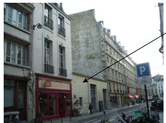
周辺の建築物と高さが合わない建築物
