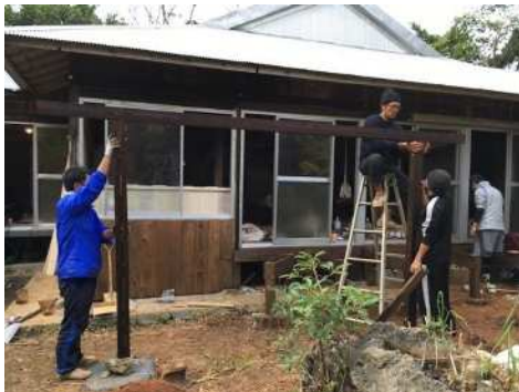
▲空き家改修風景
