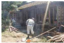
▲空き家の改修
