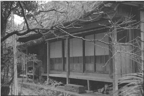
写真3 解体前 「おもて」外観 南東側
