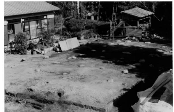
写真7 解体工事 礎石の状況
