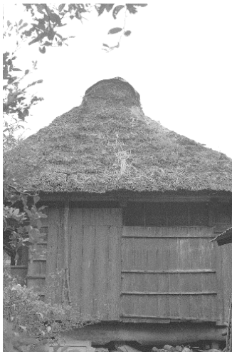
写真4 解体前 「おもて」外観 東側
