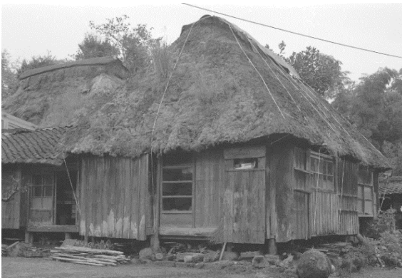
写真2 解体前 「なかえ」外観 北西側
