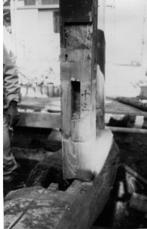
写真6 解体工事 旧番付「十三」番
