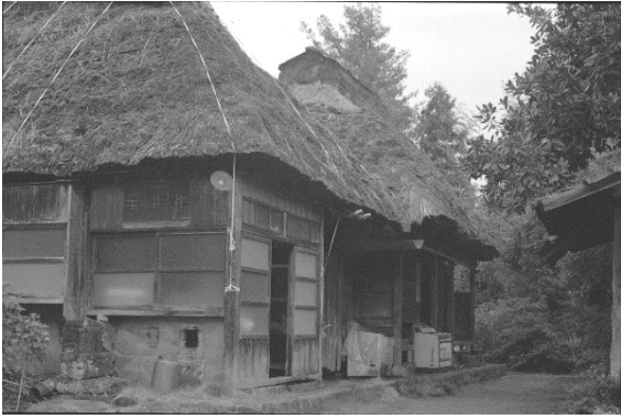
写真1 解体前 「なかえ」外観 南西側
