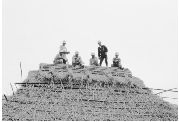
写真13 棟上げの様子（「おもて」の上部）
