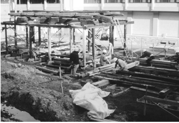
写真9 「おもて」建方 桁・梁組立
