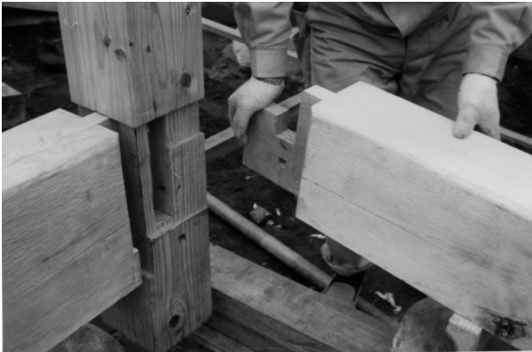
写真10 「なかえ」建方 大黒柱と上框の仕口
