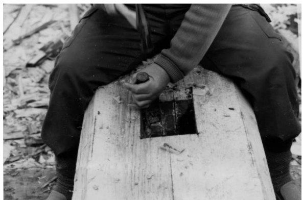
写真8 柱取合仕口の取替材加工
