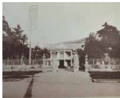
鹿児島県庁写真(明治12年建築) 『鹿児島県写真帖』 (玉里島津家資料)明治40(1907)年
