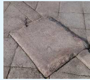
▲ 礎石に残る柱の痕跡
