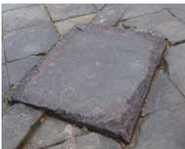
▲礎石に残る柱の痕跡
