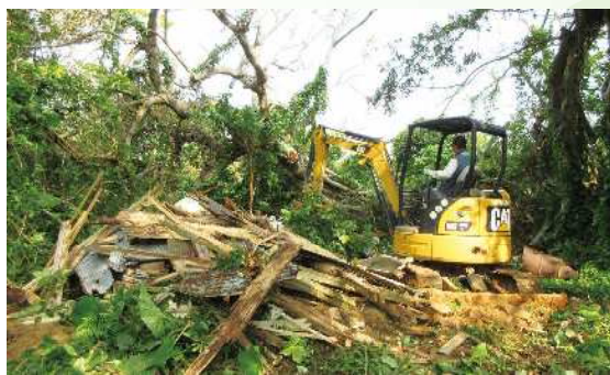
改修困難な危険家屋の解体と撤去 重機を借上げ、危険家屋の解体撤去と美化活動に取り組んでいます。
