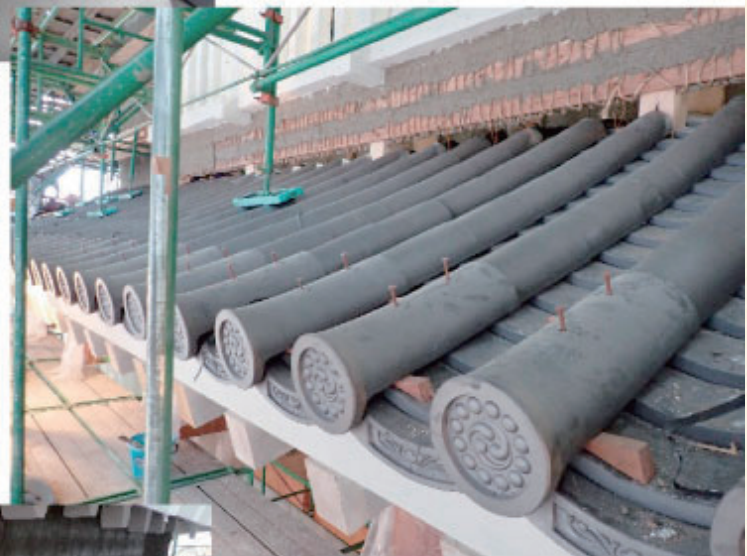
下層屋根 軒巴瓦、素丸瓦葺き →
