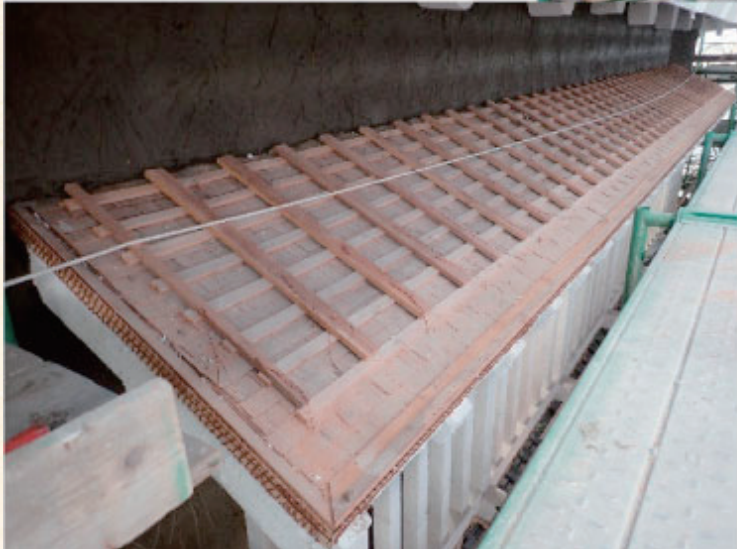
← 出窓部分 瓦棧木取付け
